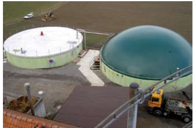
Biogasanlage Uttewil (Bösingens) Kanton Freiburg
