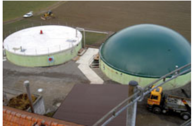
Installation de biogaz à Uttewil (FR)
