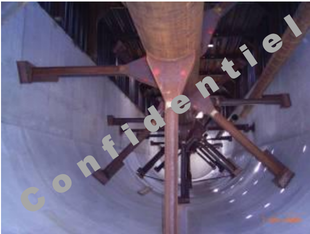
L'agitateur monté avec la couverture déjà soudée
