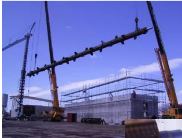
Pose de l'arbre d'agitateur
