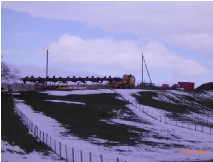
L'arbre d'agitateur du digesteur (longueur: 32 m)
