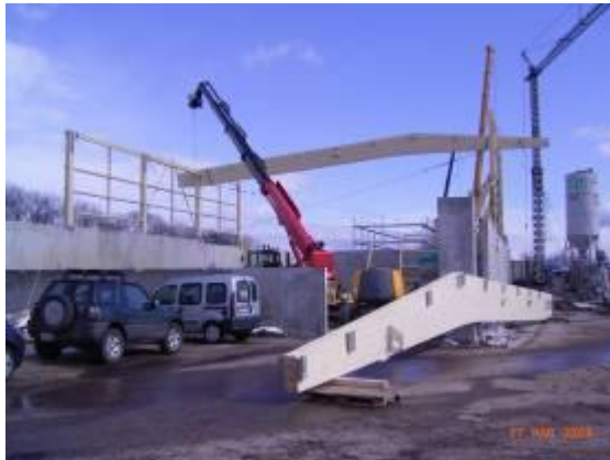
Construction du toit de la halle
