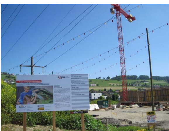
Einmalig: In Wauwil entsteht die erste Vergärungs-Anlage der Schweiz, die das Treibhausgas CO 2 kompensiert.
