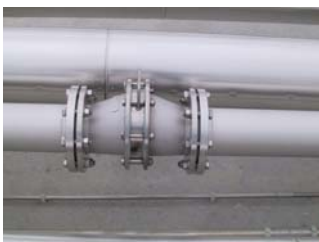
Absperrklappen nach Fermenter mit Gasspeicher
