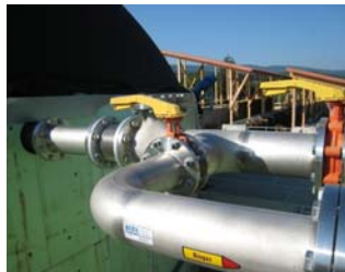
Absperrklappen nach Fermenter mit Gasspeicher
