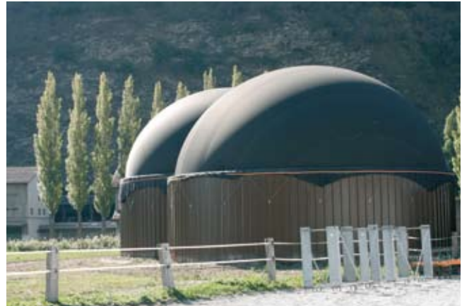
Die beiden Fermenter der Biogasanlage Visp.
