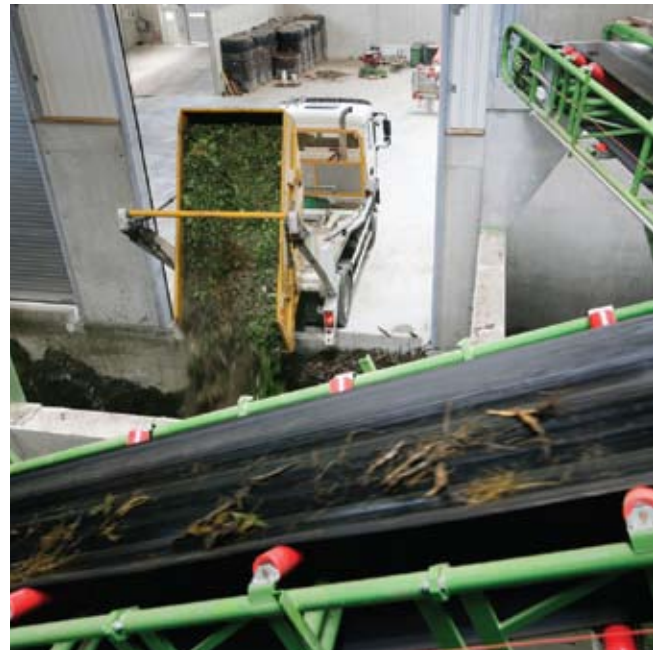
Die Anlieferung erfolgt in geschlossenen Hallen, in der ein automatisches Schleusensystem dafür sorgt, dass die gesamte Abluft über den Biofilter gereinigt wird.
